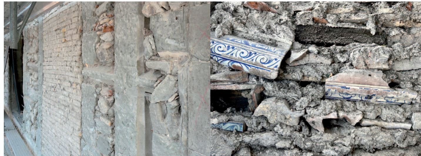
Traces d'anciens encadrements et anciennes ouvertures comblées en briques.
